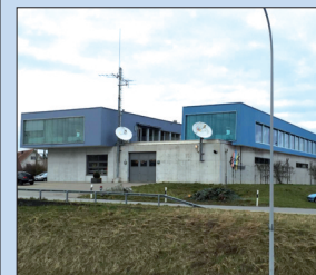
Ansicht des EWK-Ausbaus. (Bild: zvg)
