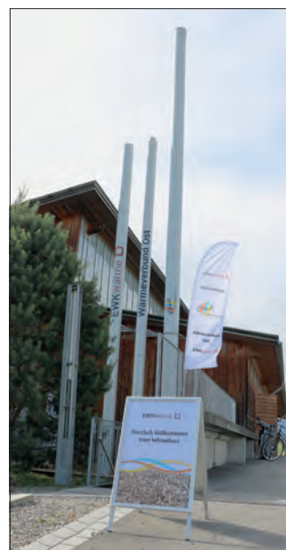
Die Zentrale des Wärmeverbundes Buchsi Ost bei der Sporthalle Mittelholz in Buchsi. (Bild: ewk)
